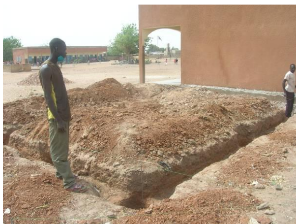
Construction d'une salle de transcription
