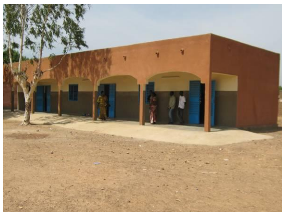
Trois classes construites dans une école décentralisée
