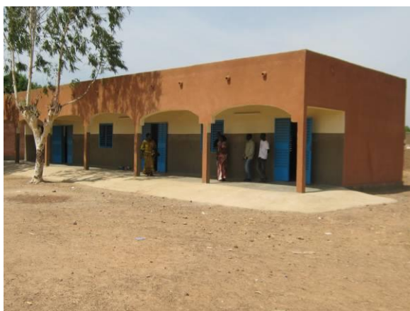
Trois classes construites dans une école décentralisée
